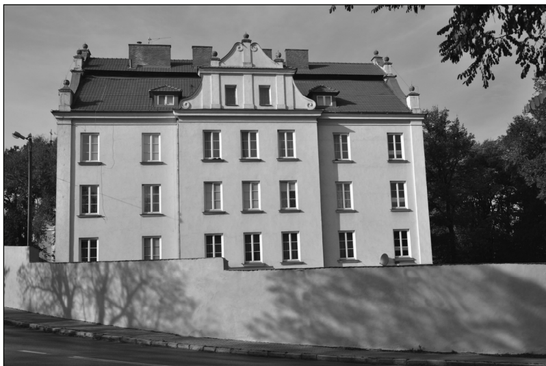
Widok od strony północnej
